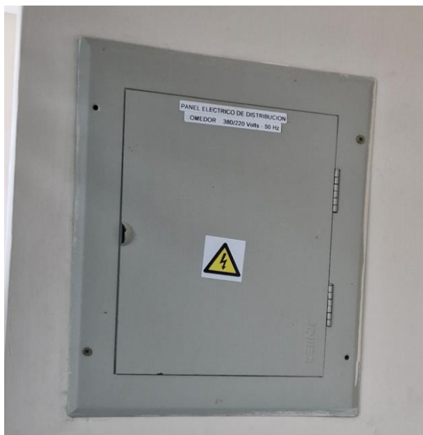
Figura 21. Tablero alimentación comedor (interior sala de control)
