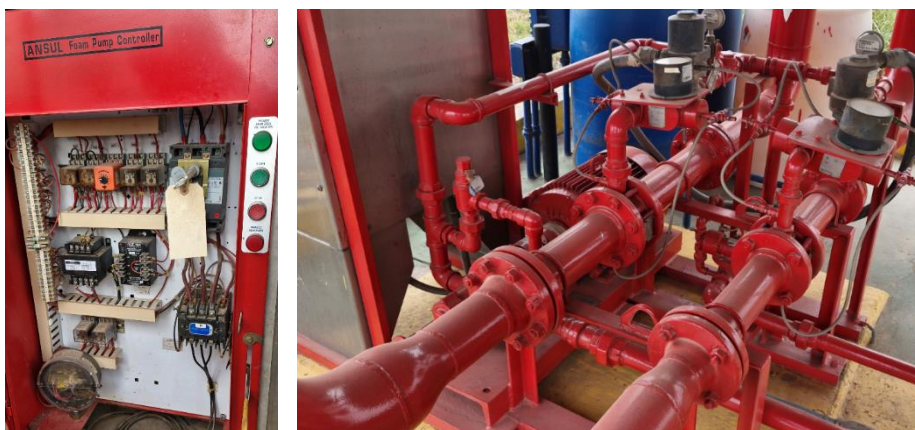
Figura 8. Panel de bomba de espuma parte interna y bombas del sistema
