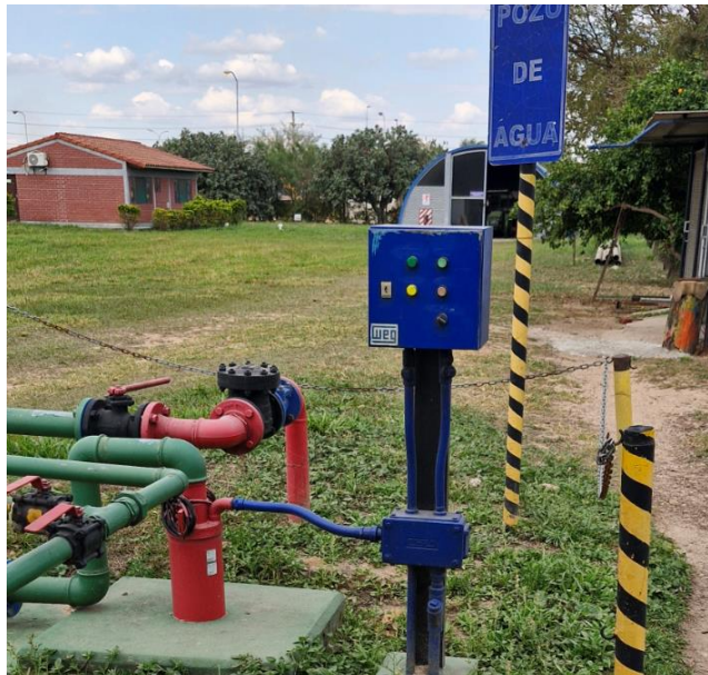
Figura 11. Bomba de agua sumergible y Panel de control
