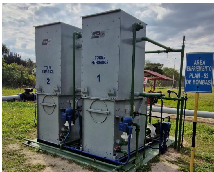
Figura 15. Torres de enfriamiento de unidades de bombeo
